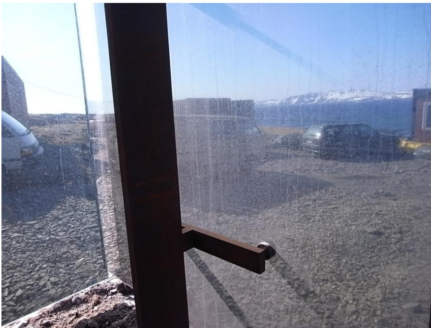
Vervuiling door zilt milieu, zowel binnen- als buitenzijde van het gelaagde glas
